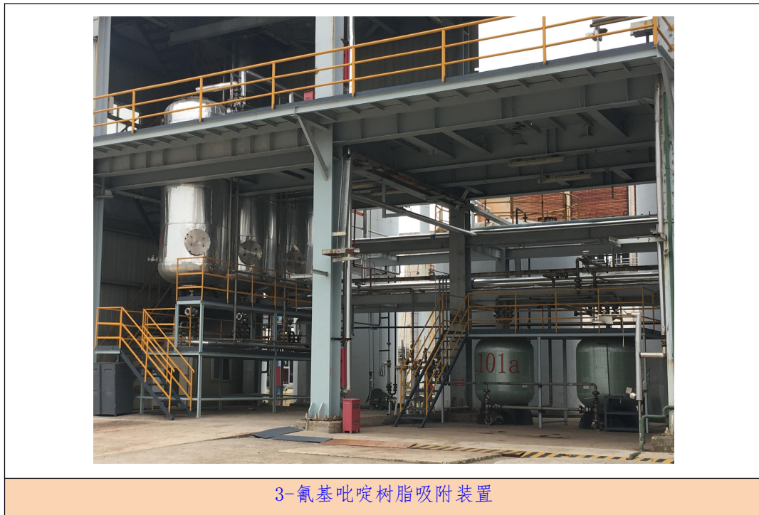
图 1.2 公司废水预处理装置
